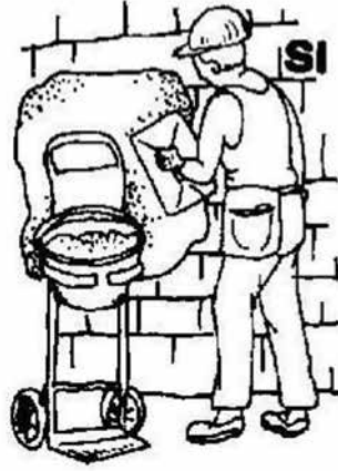
Intonacatura: utilizzare appositi supporti in modo da alzare il punto di presa della malta
