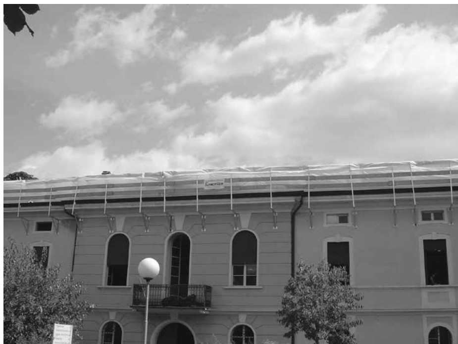
Sistemi provvisionali di protezione bordi tetti
