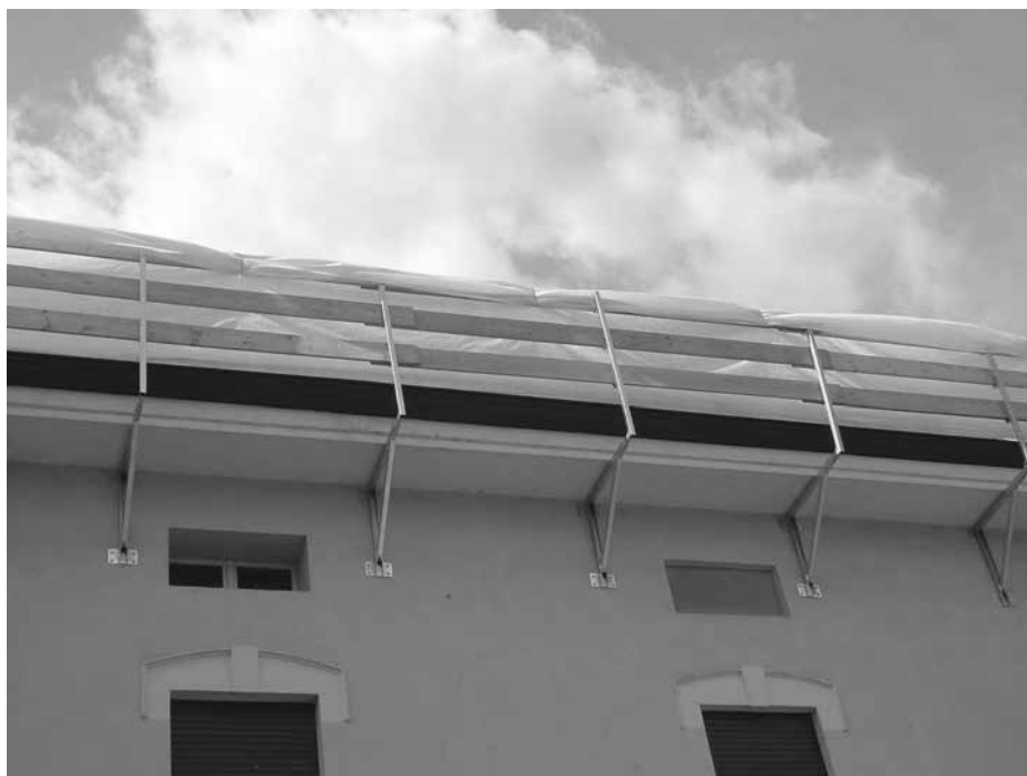
Sistemi provvisori di protezione bordi tetti
