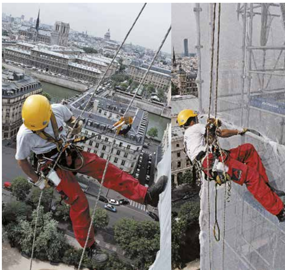
Lavori in sospensione con adeguata imbracatura e doppie funi ancorate separatamente.
