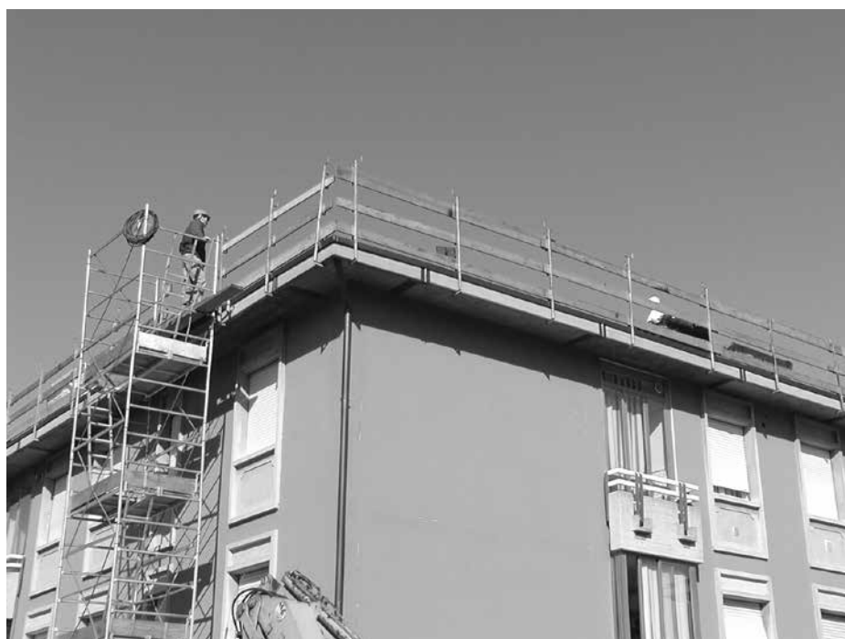
Sistemi provvisionali di protezione bordi tetti
