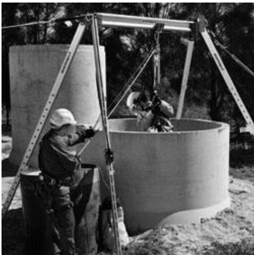
Figura 5. Ancoraggio mobile a cui fissare mezzi anticaduta o per il recupero persone. Lunghezze standard 2 m, 3 m e 4 m. Progettato per operare con più persone.
