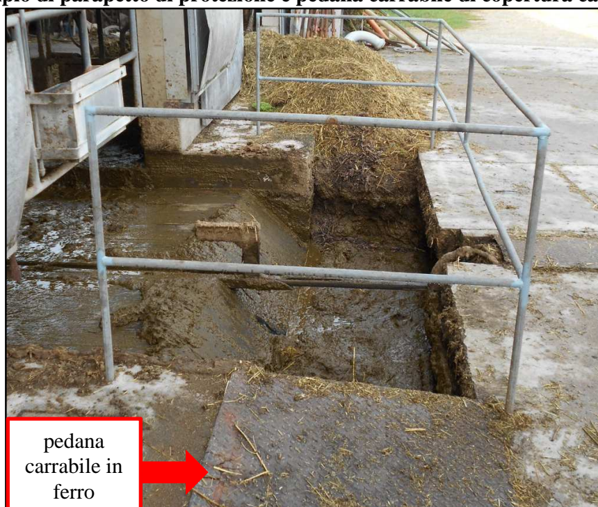
Esempio di parapetto di protezione e pedana carrabile di copertura canalette
