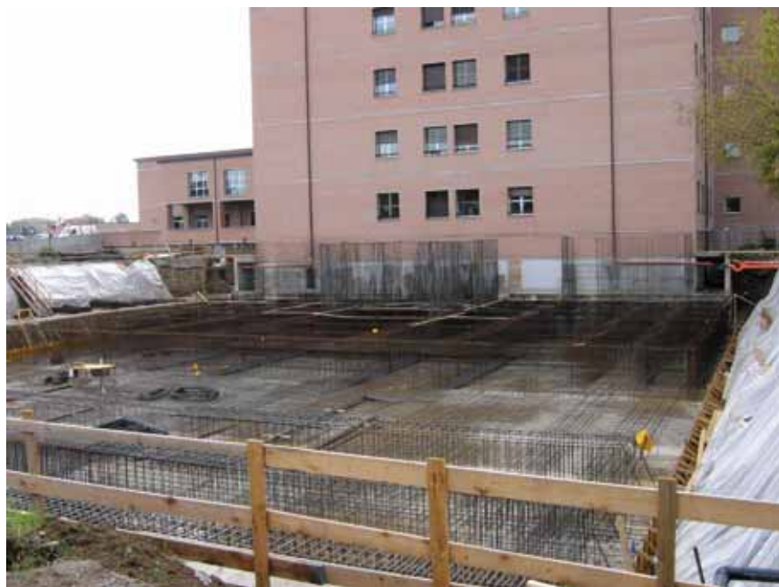
1) Armature della fondazione tipo a "platea nervata".
